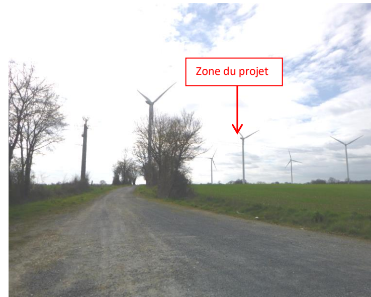
Perception n°14 : Vue depuis la voie D741
